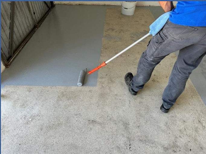
Sekoitetaan ja levitetään kahteen kertaan lyhytkarvaisella telalla
