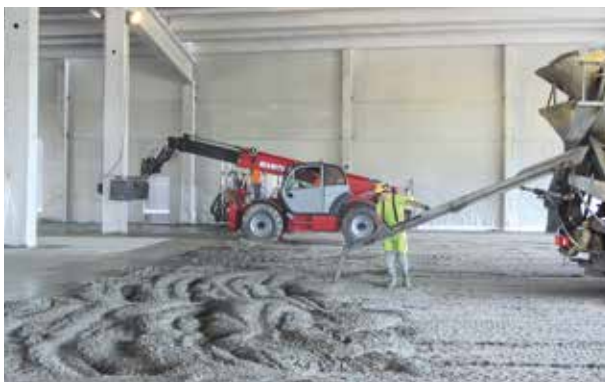
Kuitubetonia käyttäen valutyö helpottuu.
